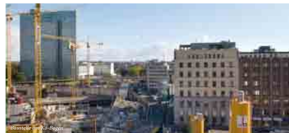
Baustelle am Kö-Bogen
