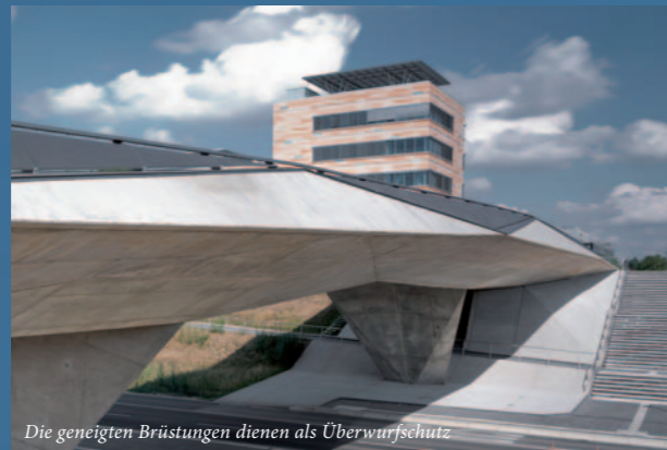
Die geneigten Brüstungen dienen als Überwurfschutz
