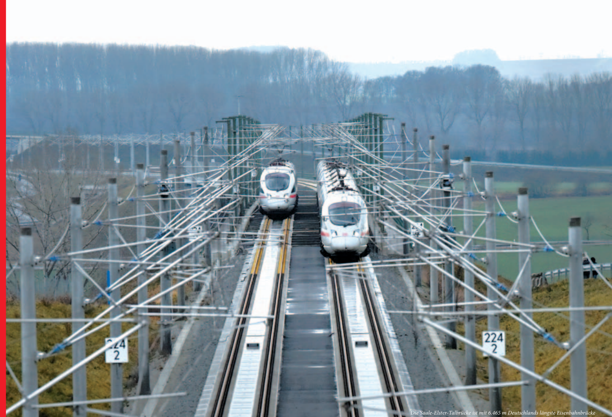
Die Saale-Elster-Talbrücke ist mit 6.465 m Deutschlands längste Eisenbahnbrücke
