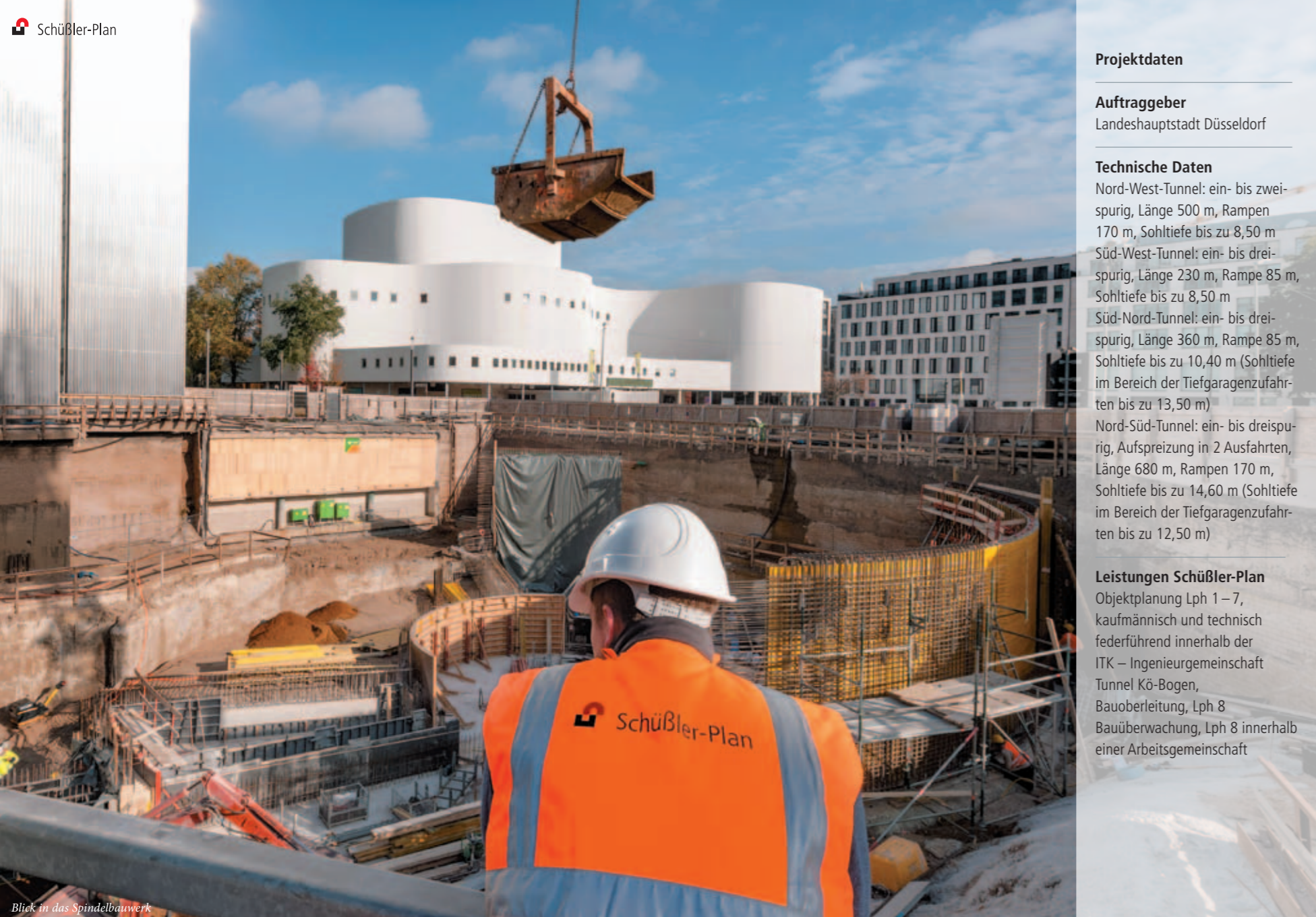
Blick in das Spindelbauwerk
