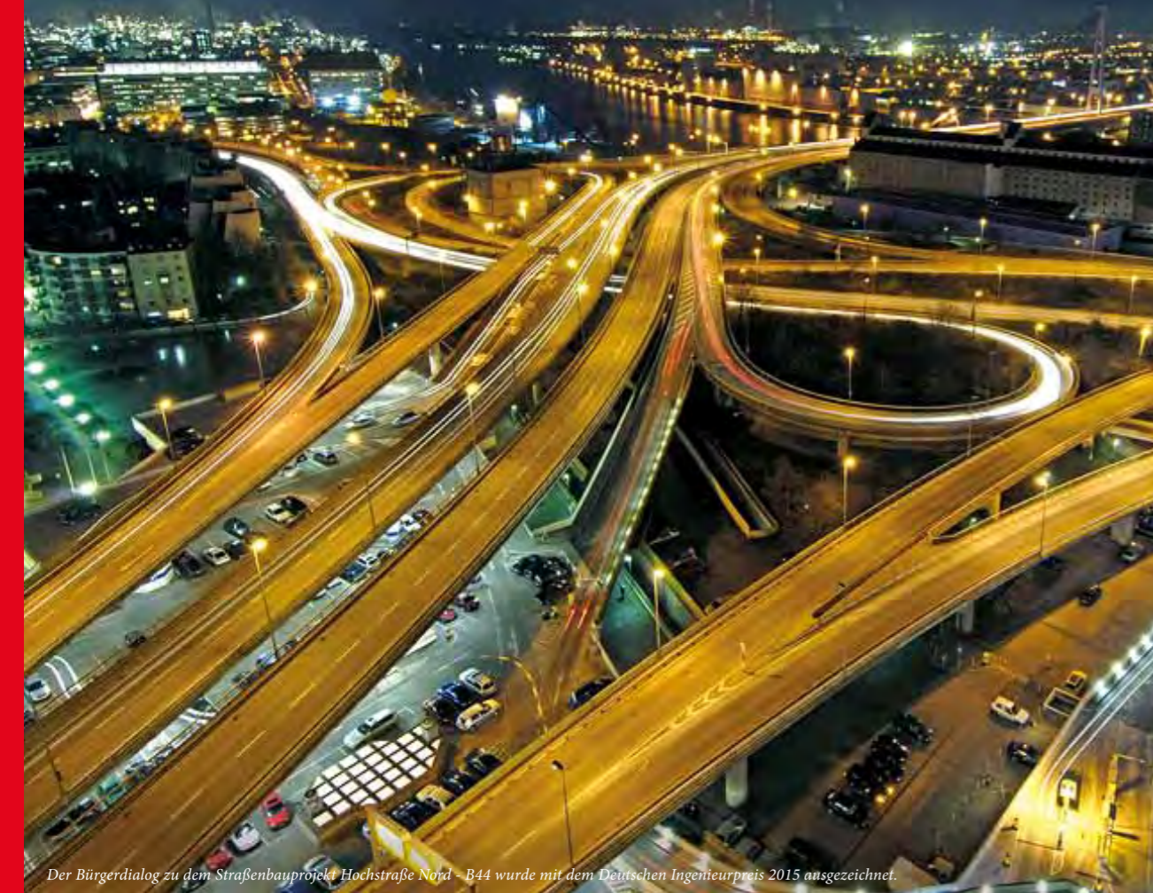
Der Bürgerdialog zu dem Straßenbauprojekt Hochstraße Nord – B44 wurde mit dem Deutschen Ingenieurpreis 2015 ausgezeichnet.
