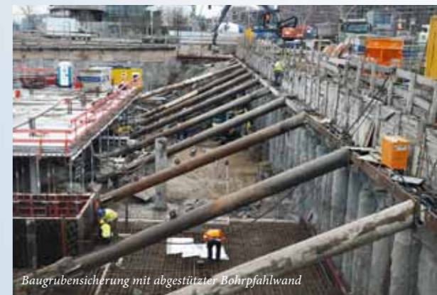
Baugrubensicherung mit abgestützter Bohrpfahlwand
