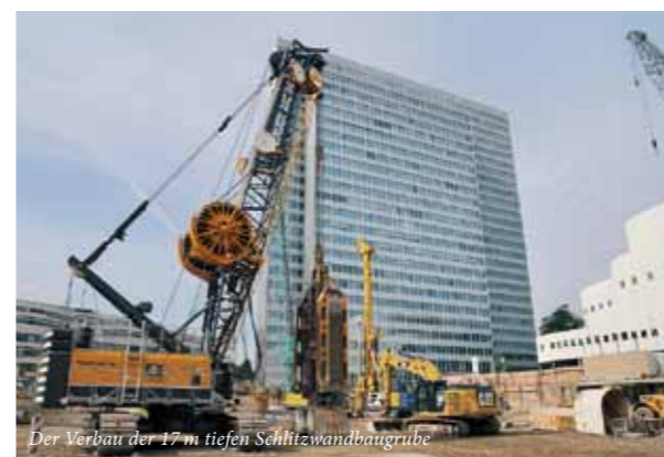
Der Verbau der 17 m tiefen Schlitzwandbaugrube
