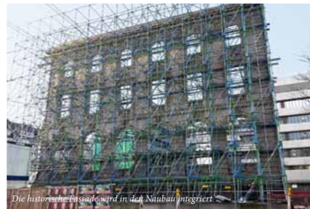
Die historische Fassade wird in den Neubau integriert
